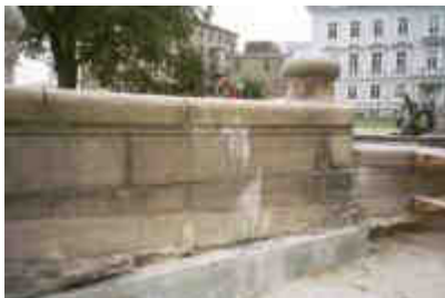
Der Springbrunnen vor der Fugensanierung. Die Spalten wurden bis zu einer Tiefe von 50 mm gesäubert.
