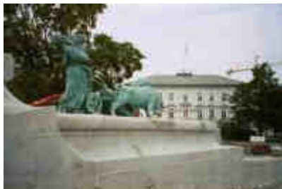
Insgesamt wurden ungefähr 200 Meter Fugen des Gefion Springbrunnens saniert.
